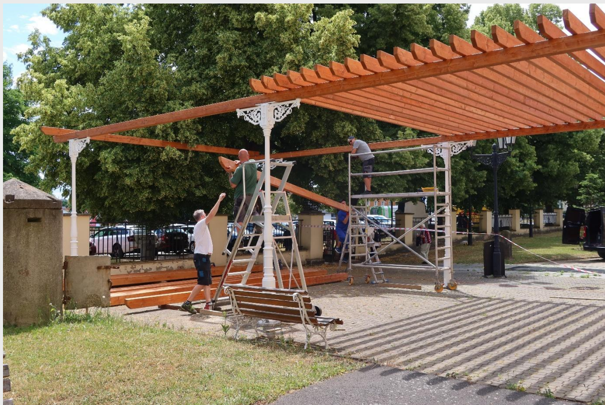
Rekonstrukce pergoly před hlavním vchodem budovy muzea
