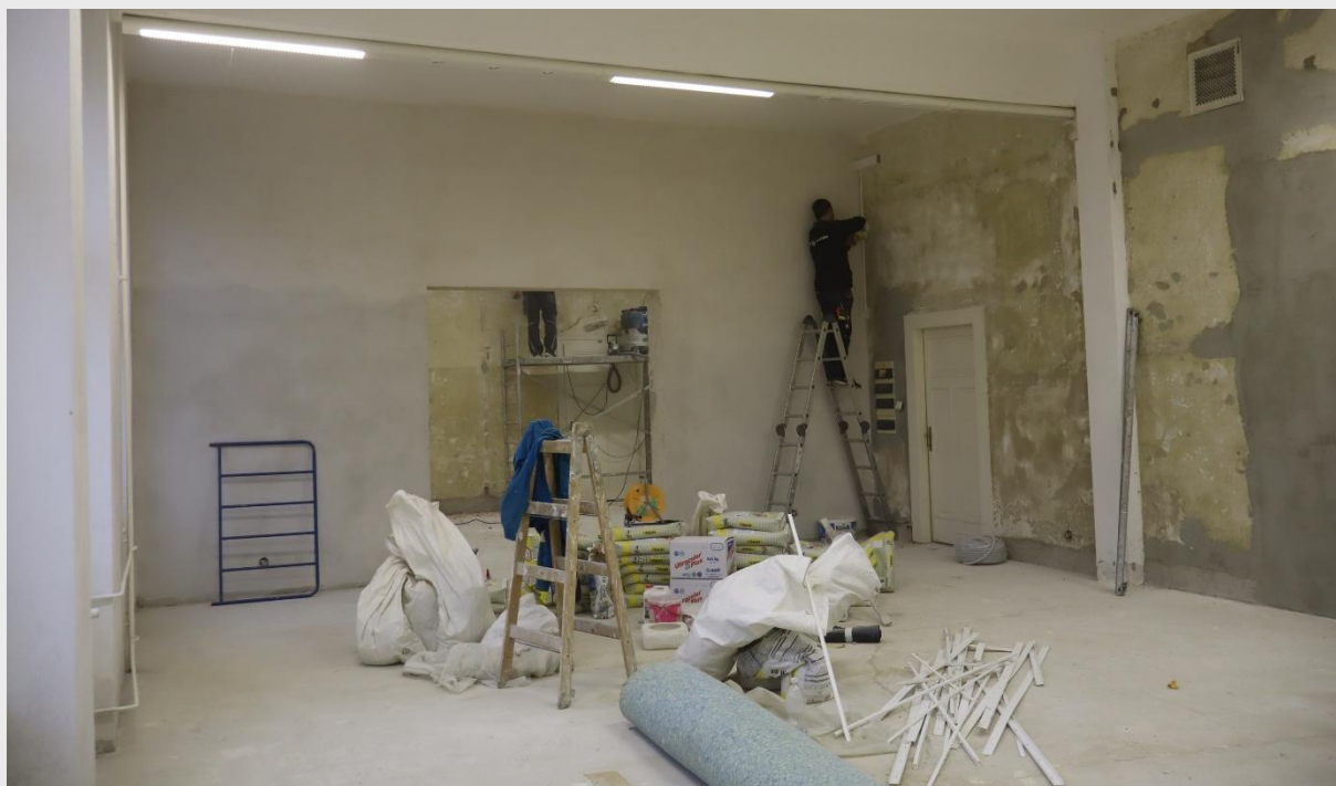
Rekonstrukce podlahy budoucích výstavních prostor
