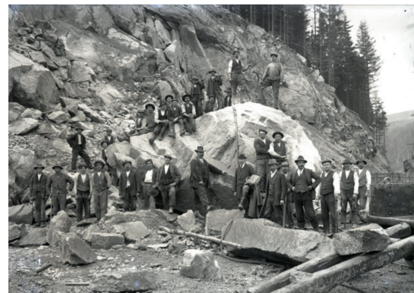
Janovská přehrada v průběhu prací na úpravě terénu v místě hráze (1911).
