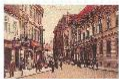
Nádražní ulice směrem na 1. náměstí r. 1908 Most
